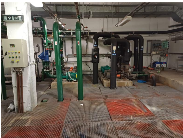
Oběhová čerpadla primárního a sekundárního okruhu
